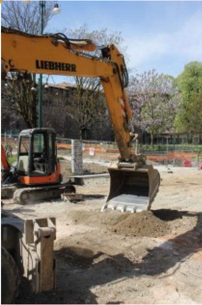
Fig. 51d - 11 aprile 2022: con eleganza e noncuranza si autorizzano i lavori in Piazza Castello. Le ruspe scavano sopra il rinascimentale Baluardo Albuquerque ignorandone l'esistenza e nell'intento di piantumarvi decine di aceri. I 12 milioni di euro stanziati dal Comune non servono a preservare e valorizzare le opere archeologiche e architettoniche del passato.
