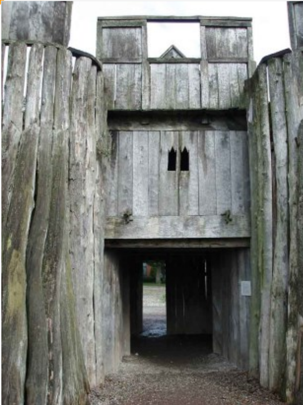
Fig. 10b - Ricostruzione della «porta a tenaglia» lignea del Treelleborg fort di Trelleborg in Svezia. Veduta esterna della porta incassata nel terreno.
