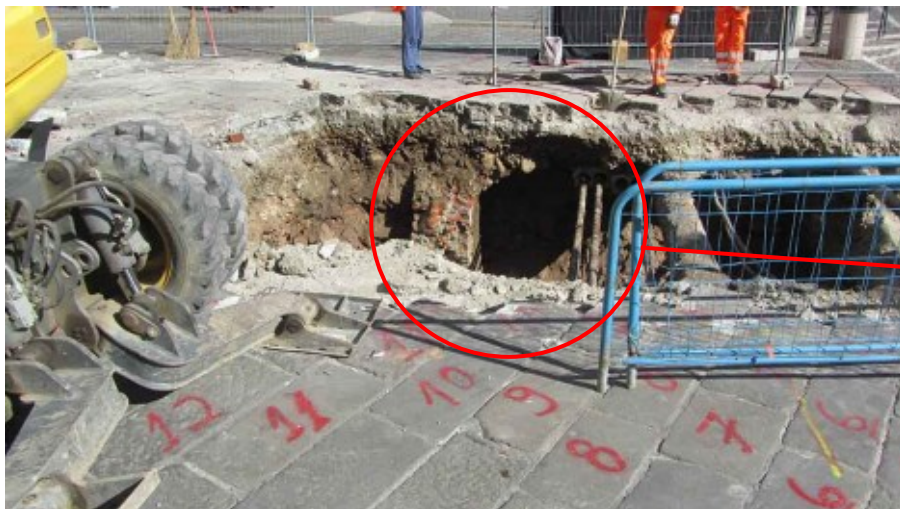
Fig. 51 - 13 marzo 2015: tra il Duomo e l'Arcivescovado si demoliscono allegramente le architetture del passato per fare passare "quattro tubi".
