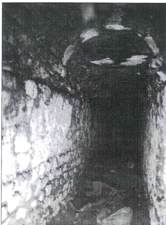
Figura n° 8. L'interno del cunicolo a valle dell'acquedotto di Mompiano presso casa Cavadini (foto D. Gallina).
