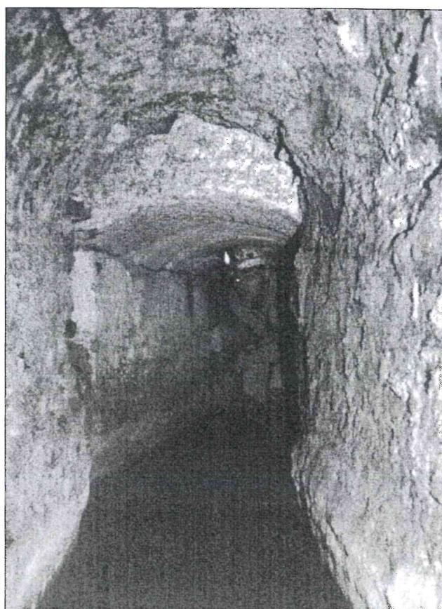
Figura n° 9. Il punto di ingresso del condotto a monte entro il perimetro urbano romano (foto D. Gallina).
